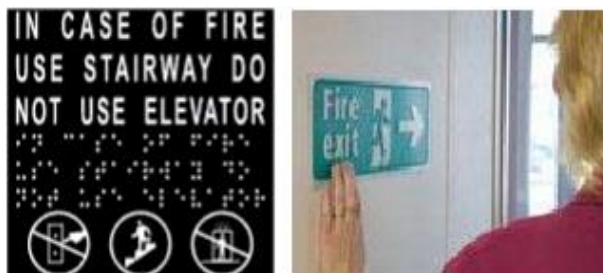
Εικόνα 14. Σήματα διαφυγής σε ανάγλυφη γραφή τυφλών (Braille) για να μπορούν να διαβαστούν από άτομα με προβλήματα όρασης (NFPA, Σχεδιασμός Εκκένωσης σε Έκτακτες Καταστάσεις-Οδηγός για Άτομα με Αναπηρία, Ιούλιος 2016) [4]
